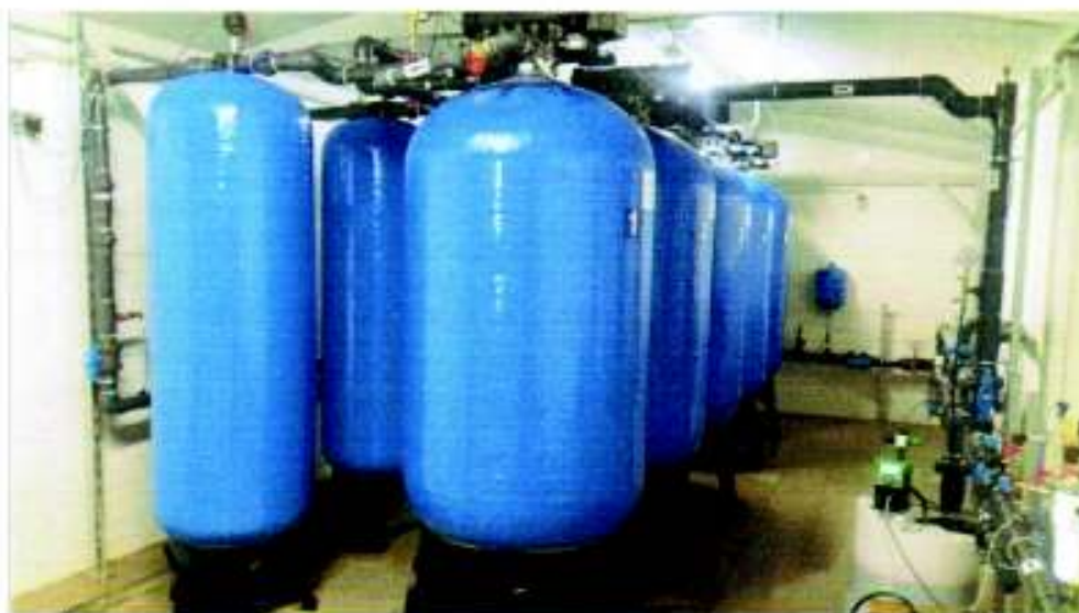
1 pav. Šveicarijos kaimo vandens gerinimo įrenginiai.
