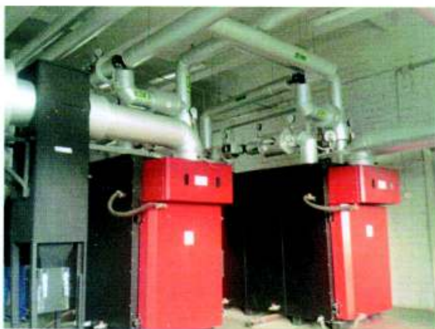
2. pav. II pakėlimo vandentiekio stoties katilinė įranga.
